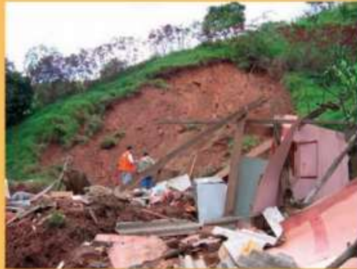
Escorregamento em Campo Largo, SP, 2009. Fonte: Acesso IG.
