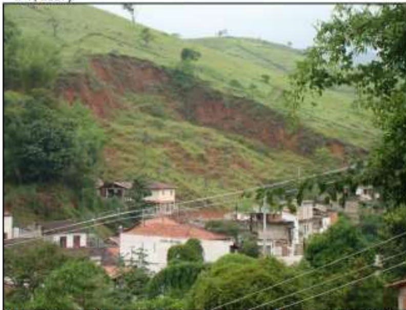
Figura 6 – Deslizamento circular ou rotacional (Fonte: Sirden-CTGeo-IPT).
