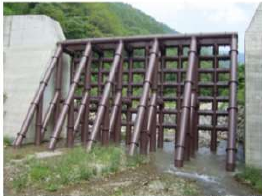
Exemplo de Barreira Sabo permeável (Mizuyama, 2008, em Manual Técnico para Concepção de Intervenções para Fluxo de Detritos).
