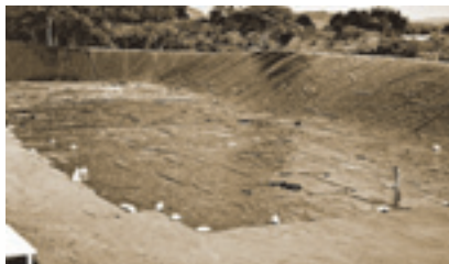
1º patamar de PEAD implantado na instalação do aterro
