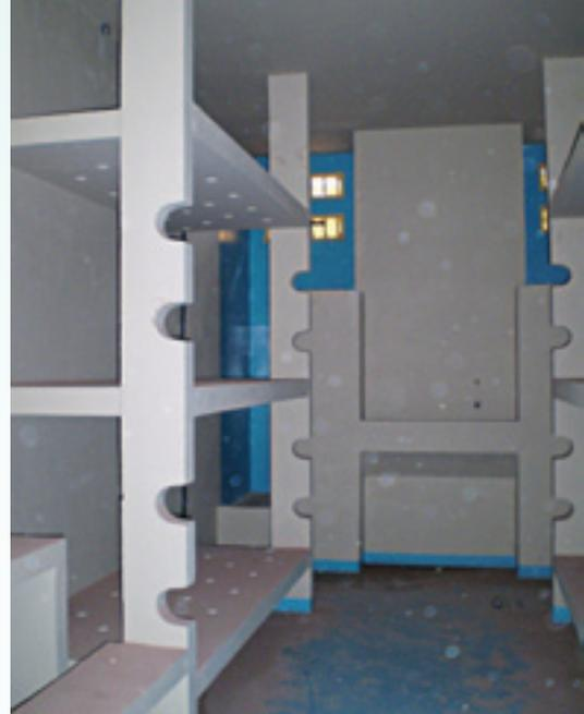
Os módulos de celas do Siscopen® são confeccionados em Concreto de Alto Desempenho (CAD) – aplicado em pisos, paredes e tetos – e complementado por peças em Glass Reinforced Concrete (GRC), como cobertura, cantoneiras das paredes e pisos e mobiliário
