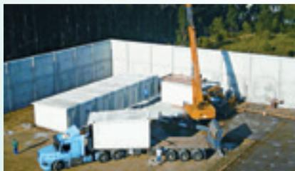
Os módulos são feitos em partes. Primeiramente, com a concretagem dos painéis em CAD. Posteriormente, esses painéis são unidos para chegar à forma de caixa. Depois de já estar em três dimensões, é inserido todo o mobiliário e, em seguida, o fechamento com o painel (teto). Todo o acabamento de pintura e porta é feito em fábrica. O módulo sai 100% acabado diretamente para a obra
