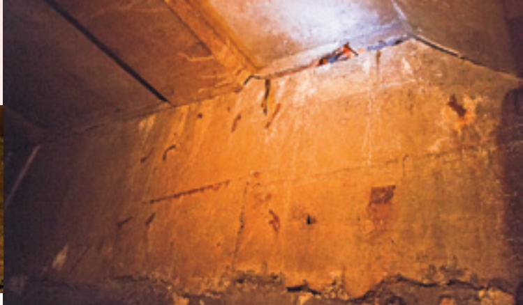
Barras de ligação rompidas entre a tampa e a parede, por esforços de tração
