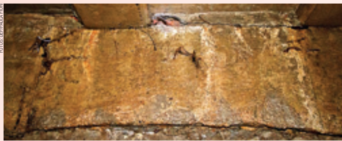
Barras de ligação rompidas entre a tampa e a parede, por esforços de tração
